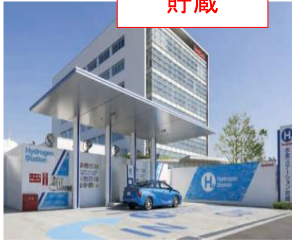
水素ステーション
